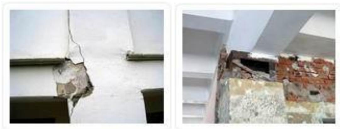
Рис. 1.1. Разрушение мест опирания несущих конструкций здания
