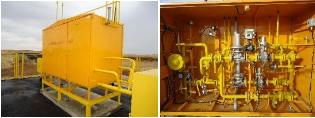
Рисунок 2.3 - Оборудование ГРПШ
