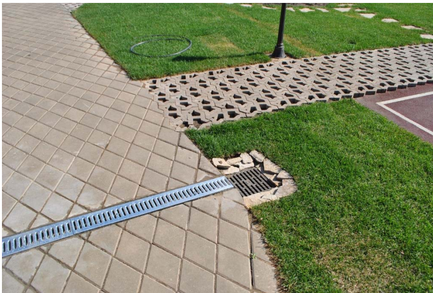
Рис. 3.2. Пример расположения дождеприемника на рекреационной территории
