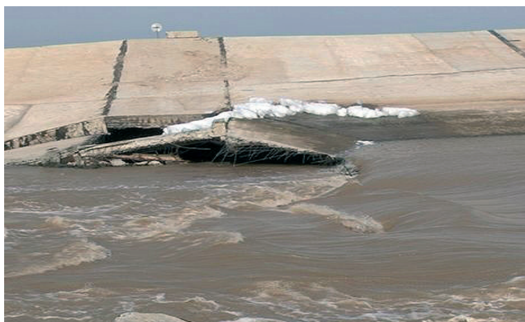
Разрушение железобетонного покрытия гребня плотины во время ледохода
