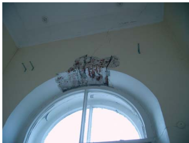
Рис. 5. Разрушение арочной перемычки над оконным проемом
