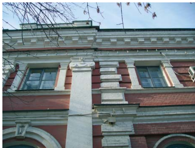
Рис. 4. Трещина в наружной стене здания в зоне пристройки
