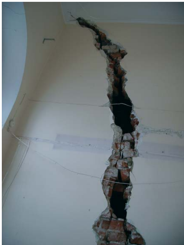
Рис. 3. Трещина в ослабленном участке стены
