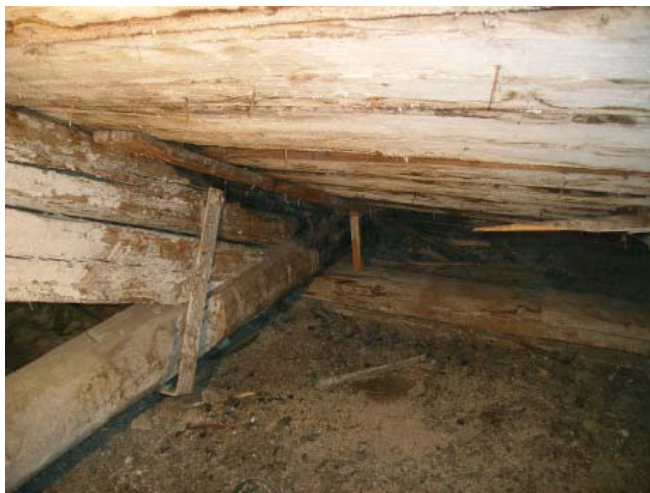
Рис. 2. Поражение гнилью элементов стропильной фермы и обрешетки
