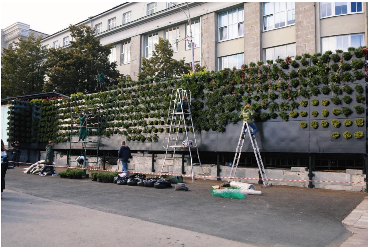
Рисунок 1 – Монтаж зеленой стены в Екатеринбурге (ул. Театральный переулок, 2А), 2025 г.
