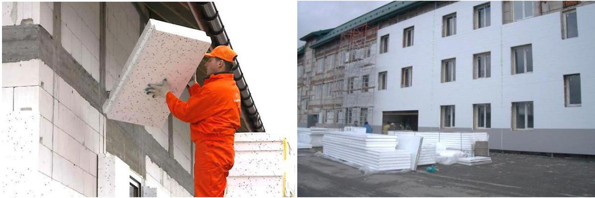
Рисунок 1 - Применение на жилых объектах пенополистерола
