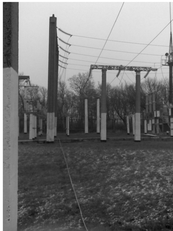
а) б) Рисунок 3 – Наклонные стойки ОРУ ПС-110 кВ «Красная Яруга» а) стойки №71, 72, 73; б) стойки №57, 58, 59
