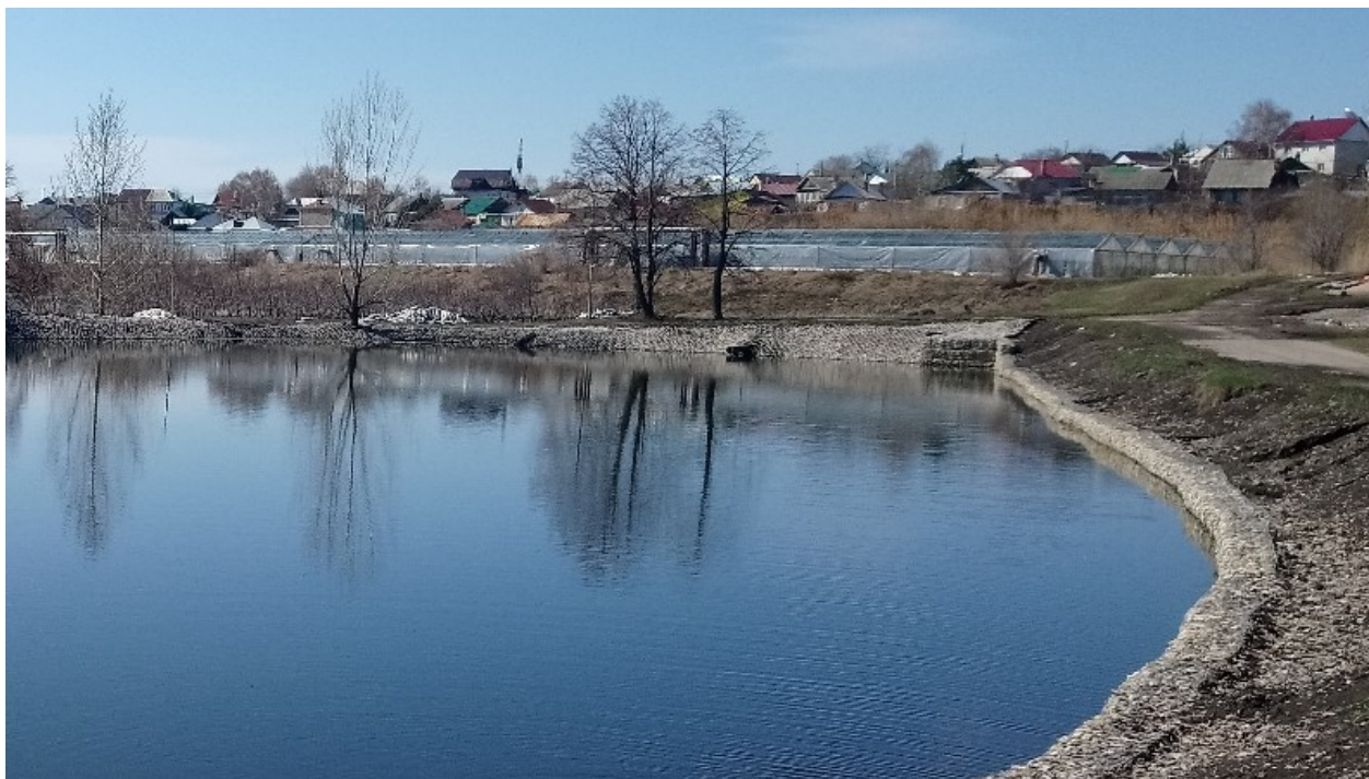
Рисунок 1 - Берегоукрепительные мероприятия на пруде «Средний»
