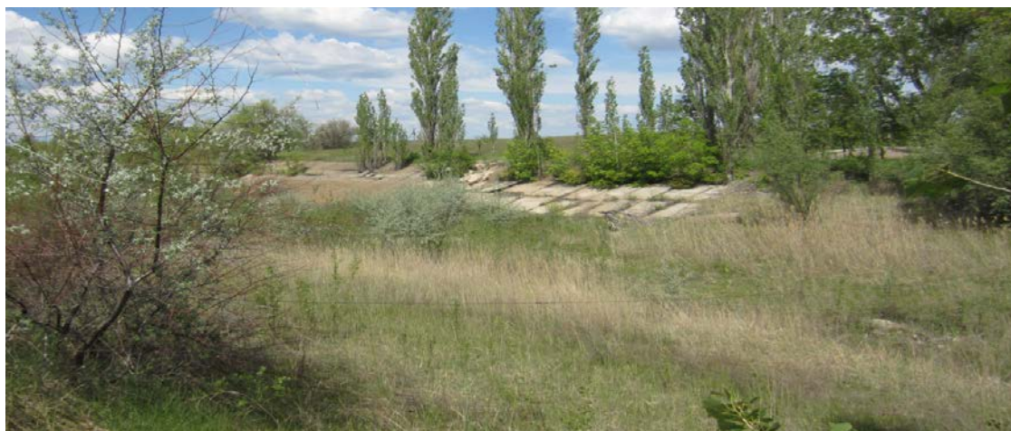
Рис. 3. Заросший участок магистрального канала в облицованном русле
