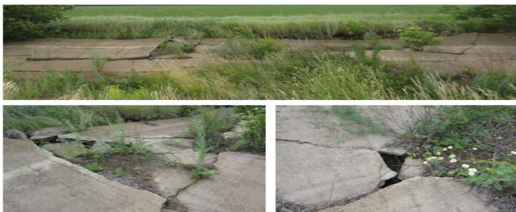
Рис. 6. Локальные проломы и провалы
