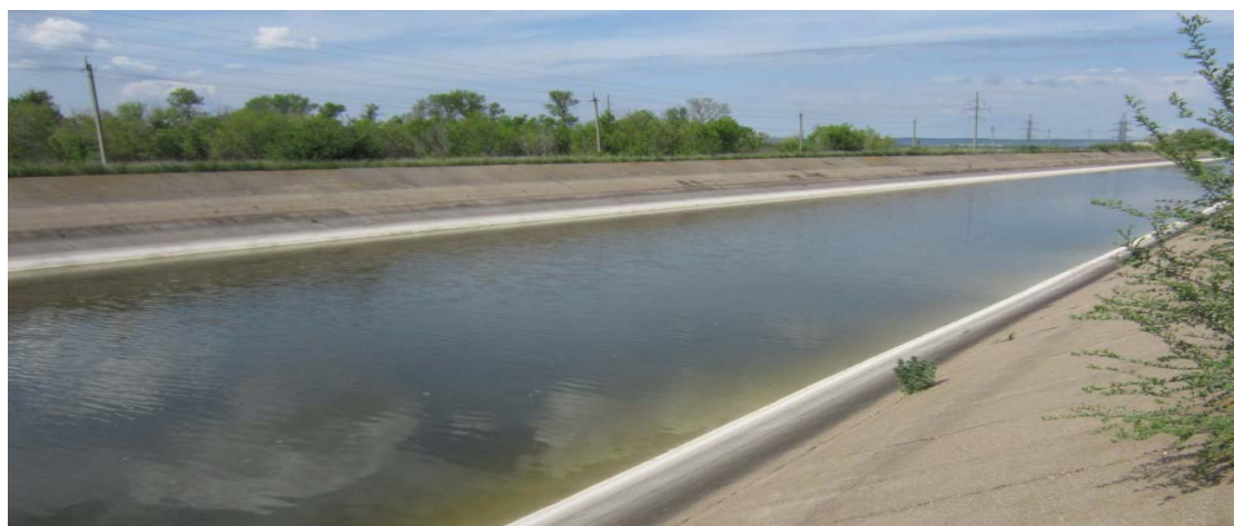
Рис. 1. Участок магистрального канала до входа в распределительный Р-2
