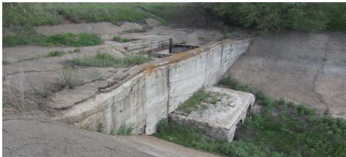
Рис. 2. Регулирующее сооружение на входе в распределительный канал Р-2
