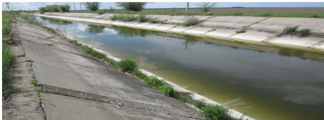
Рис. 4. Участок от магистрального канала до НСП-2
