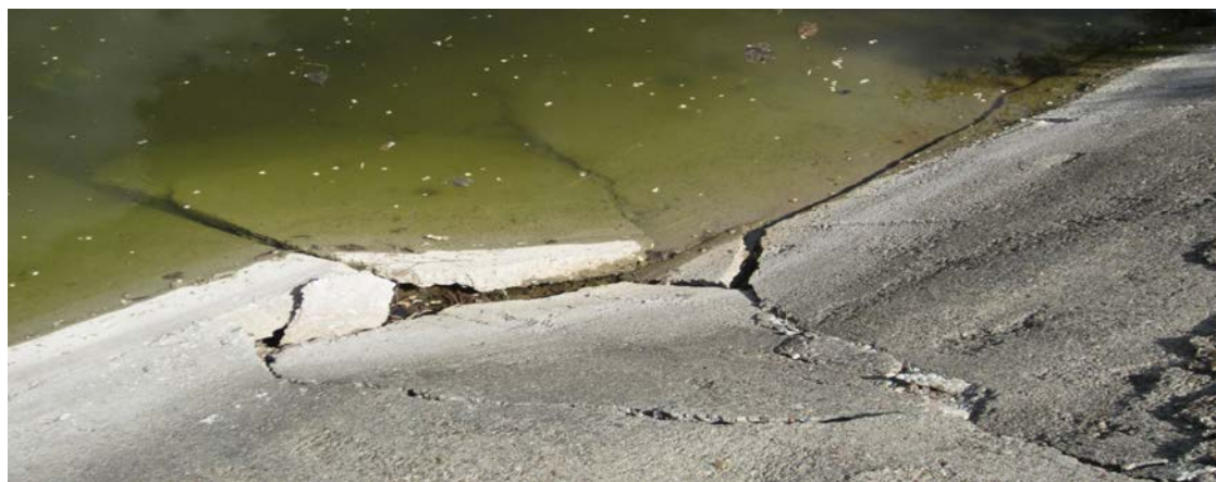
Рис. 5. Проломы облицовки в зоне переменного уровня
