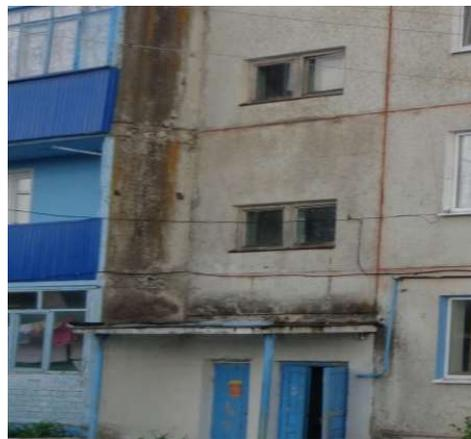
Последствия протечки кровли здания
