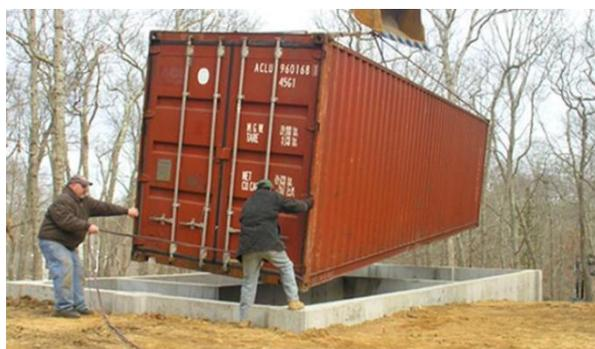
Рисунок 2. Примеры домов из контейнеров, монтируемых на столбовую и ленточную фундаментные основы
