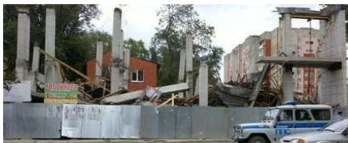
Рисунок 3. Обрушение конструкций каркасно-панельного здания
