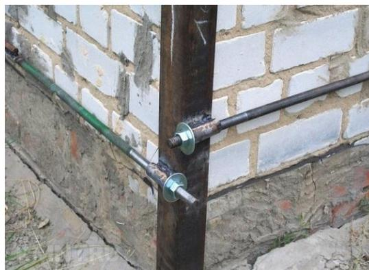
Рисунок 4. Узел сопряжения элементов усиления
