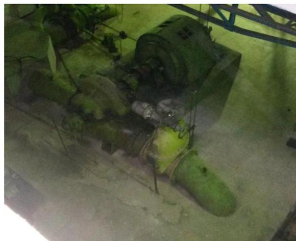
Рисунок 2. Распределительный агрегат с электроприводом от СДНЗ 15-49-10-У3.
