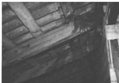
Рисунок 1. Повреждение стропильной системы кровли здания
