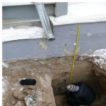
Рисунок 4. Инструментальное обследование фундамента здания
