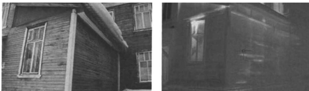
Рисунок 6. Определение теплопотерь стен двухэтажного деревянного дома
