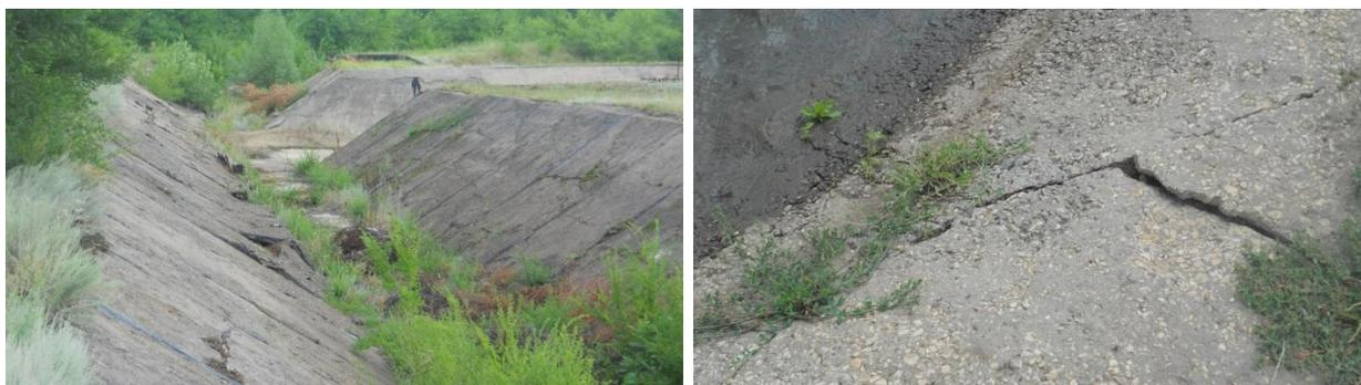
Рисунок 1. Основные повреждения облицовки канала
