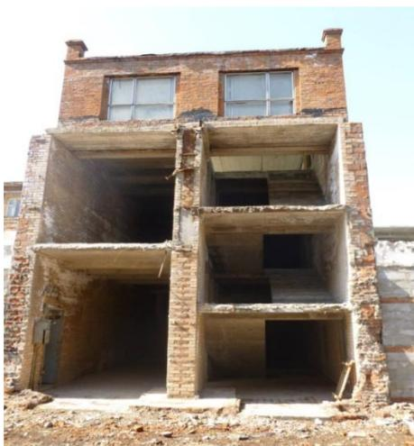
Рисунок 3. Обследование состояния перекрытий здания
