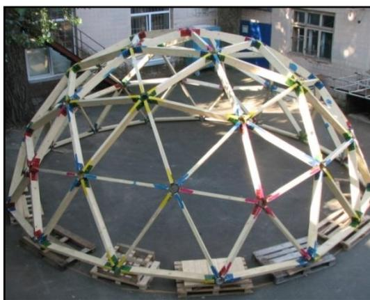
Рис. 2. Несущая конструкция купольного дома.
