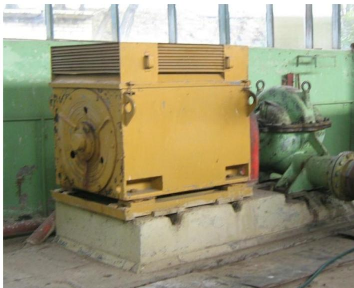
Рис. 2. Асинхронный электродвигатель ДАЗО-250-6-1000
