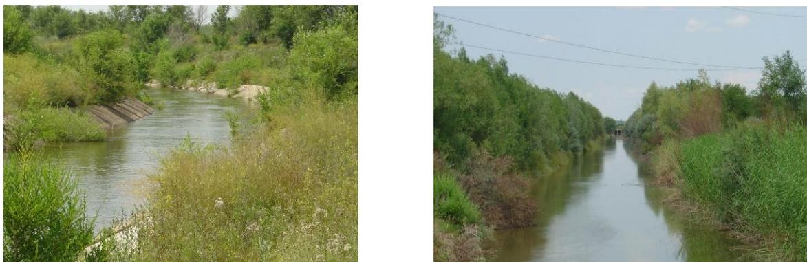
Рис. 1. Оросительный канал в облицованном и земляном русле, заросший кустарником
