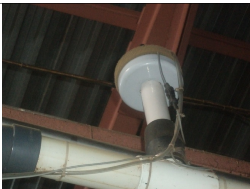
Рис.26. Антенна, воспринимающая сигналы с MooMonitor в ошейниках животных.
