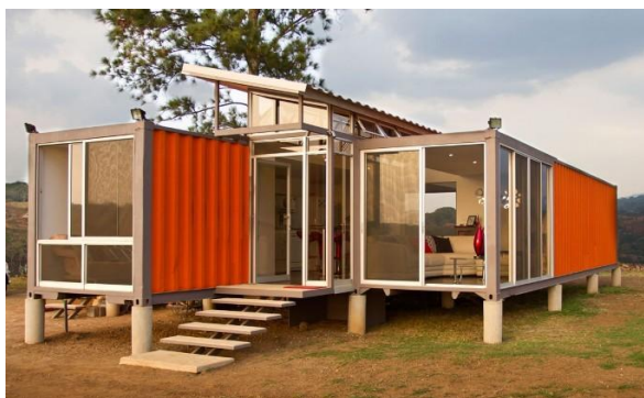
Рисунок 2. Примеры домов из контейнеров, монтируемых на столбовую и ленточную фундаментные основы
