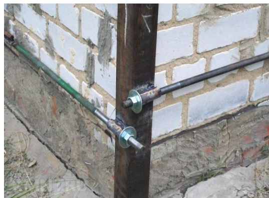
Рисунок 4. Узел сопряжения элементов усиления
