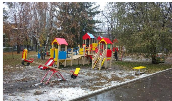
Рисунок 2. Пример отсутствия покрытия детской площадки
