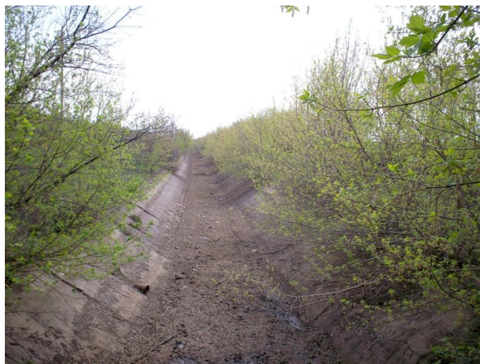
Рисунок 3. Заросший древесно-кустарниковой растительностью и заиленный участок оросительного канала.
