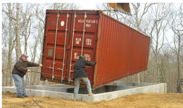
Рисунок 2. Примеры домов из контейнеров, монтируемых на столбовую и ленточную фундаментные основы
