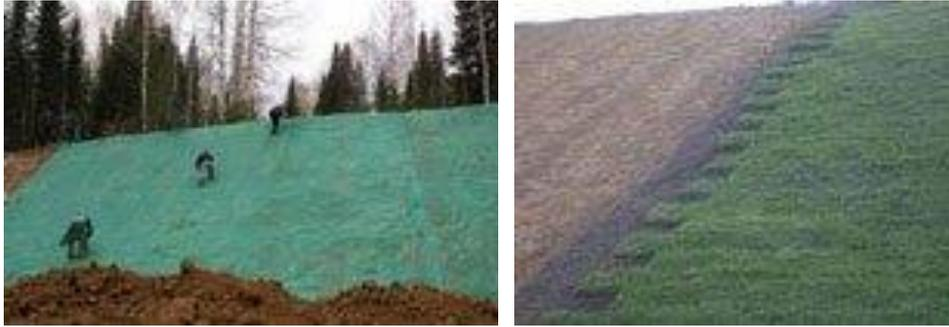
Рис. 3.3. Укрепление склонов объектов геоматами
