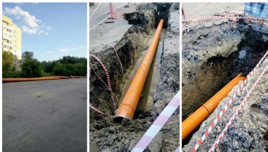
Рисунок 2. Прокладка полиэтиленовой трубы марки МУЛЬТИПАЙП II в Заводском районе г. Саратова
