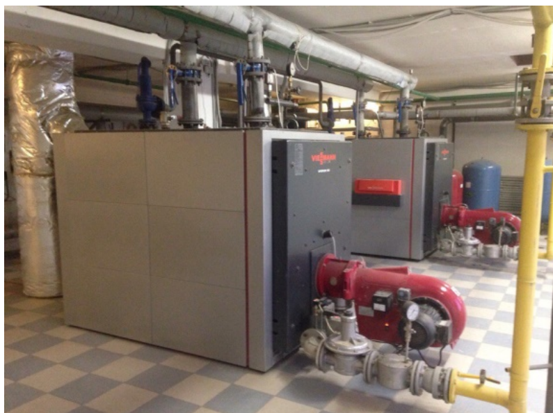
Рисунок 1. Водогрейные отопительные котлы «Viessmann»
