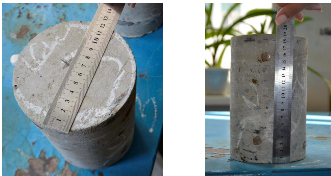
Рисунок 2. Извлеченные из массива обследуемой монолитной фундаментной плиты бетонные образцы цилиндрической формы (керны)
