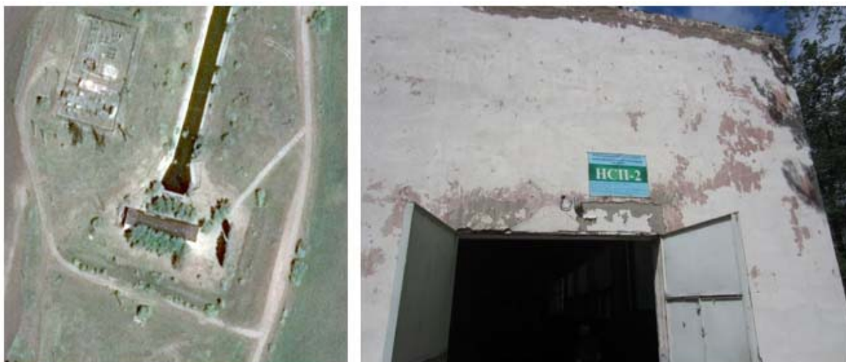
Рисунок 1. Насосная станция, перекачивающая «НСП-2»
