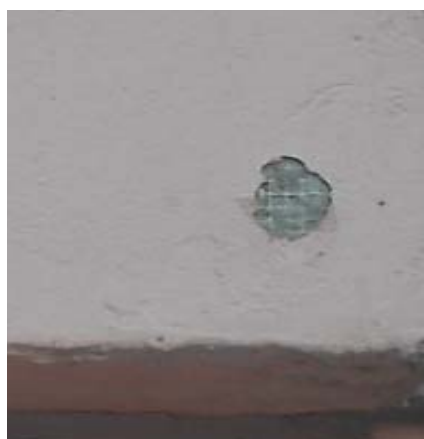
Рисунок 2. Отслаивание защитного слоя штукатурки в системе теплоизоляции
