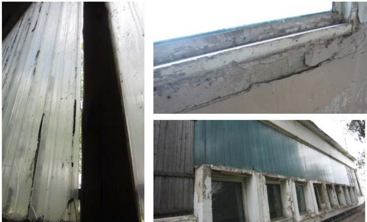
Рисунок 2. Заполнение оконных проемов здания НСП-2
